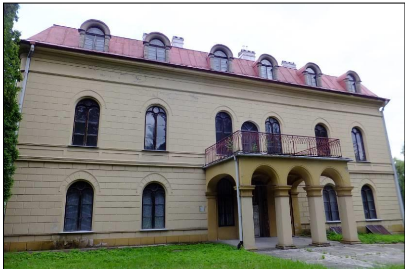
Fot. 5 Pałac od strony zachodniej
