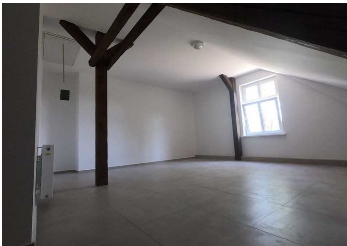
Fot. V. 14. Modernizacja budynku Przedszkola Samorządowego w Zaborzu
