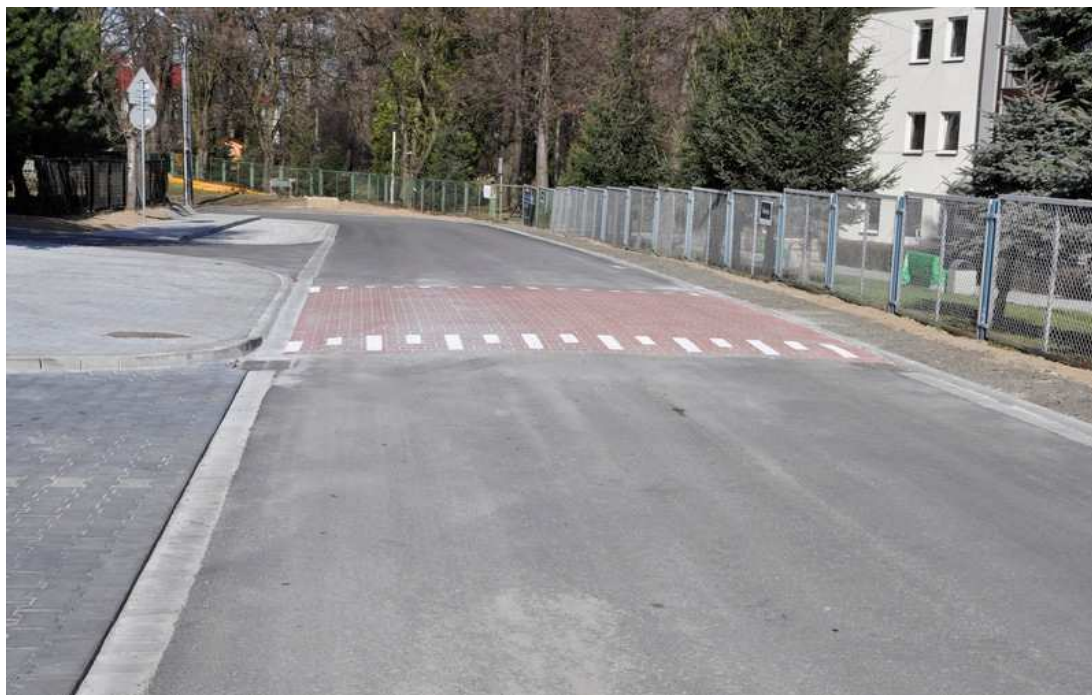
Fot. V. 5. Przebudowa ul. Al. Ogrodowej w Grojcu
