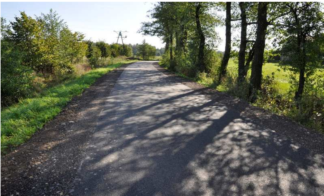
Fot. V. 10. Modernizacja ulicy Bagiennej
