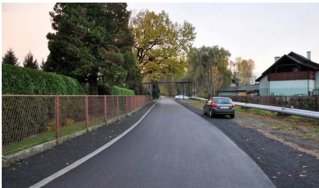
Fot. V. 13. Remont odcinka nawierzchni ul. Akacjowej w Zaborzu
