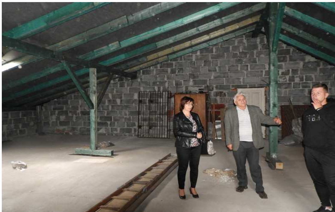
Fot. V. 8. Remont dachu garażu OSP w Porębie Wielkiej
