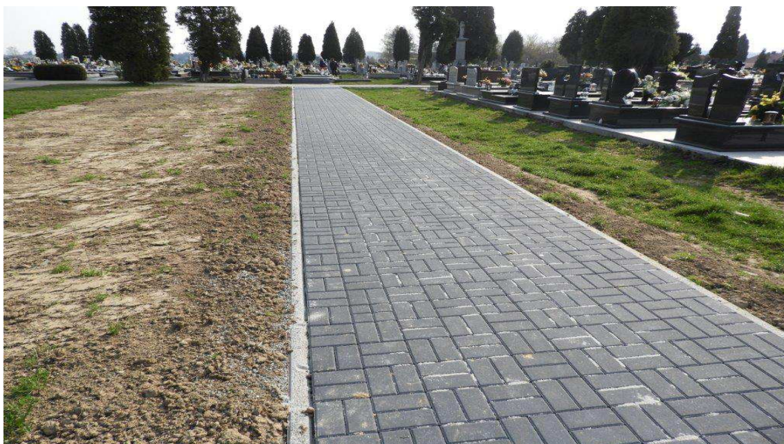
Foto. V.7. Budowa alejek na cmentarzu w Grojcu
