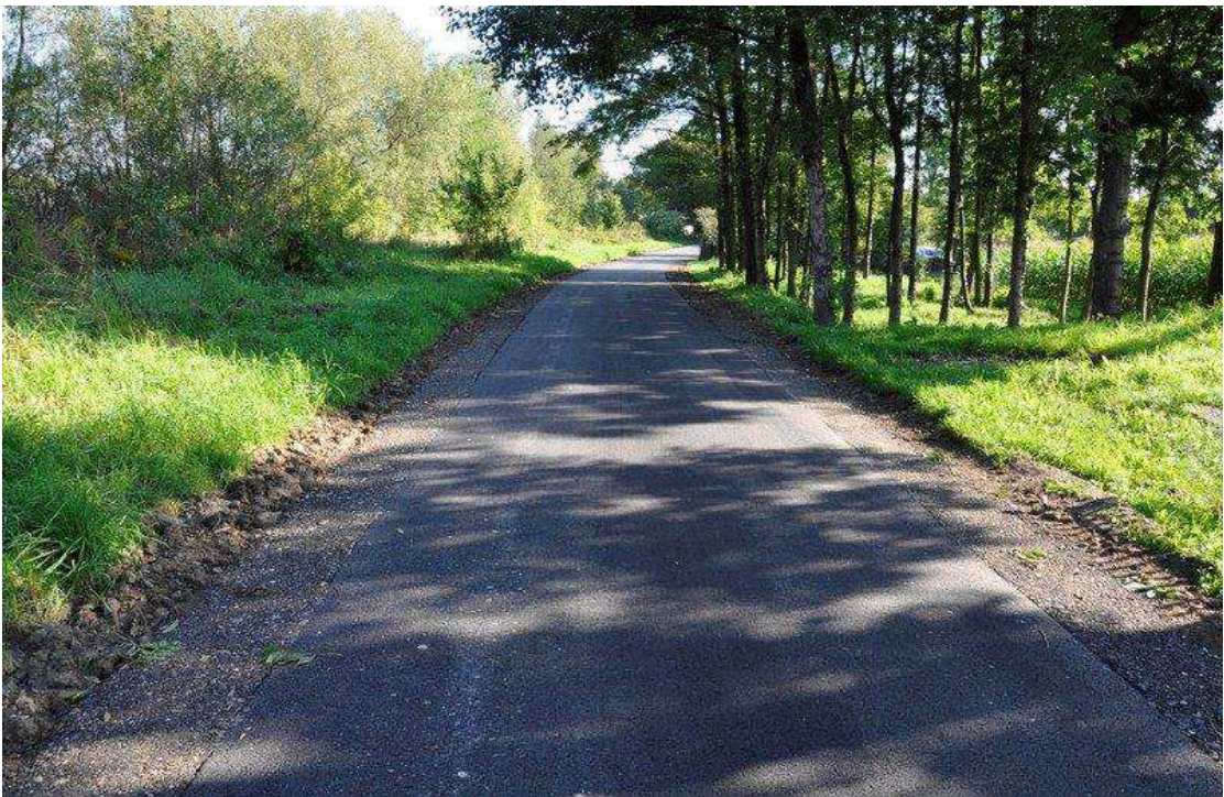
Fot. V. 12. Modernizacja ul. Wodnej w Zaborzu
