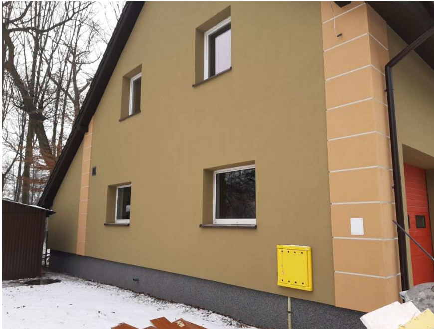
Fot.V.6. Elewacje remizy OSP Grojec.
